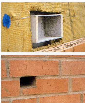
Mauerseglernistplätze hinter Klinkerfassade. Oben: Wärmedämmung um den Niststein herumziehen. Unten: Fertigansicht.
