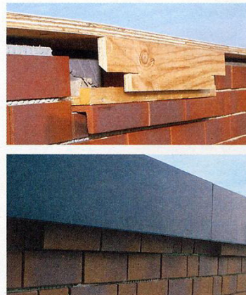
Oben: Eine Holzverkleidung unter dem Abdeckblech ist wegen der Hitzestrahlung unerlässlich. Unten: Fertigansicht.
